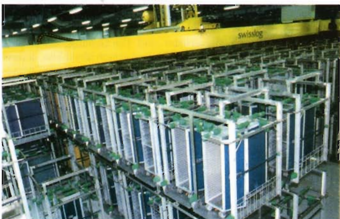
5: Gespeicherte Gehänge mit Carts im „Cart-Buffer“
