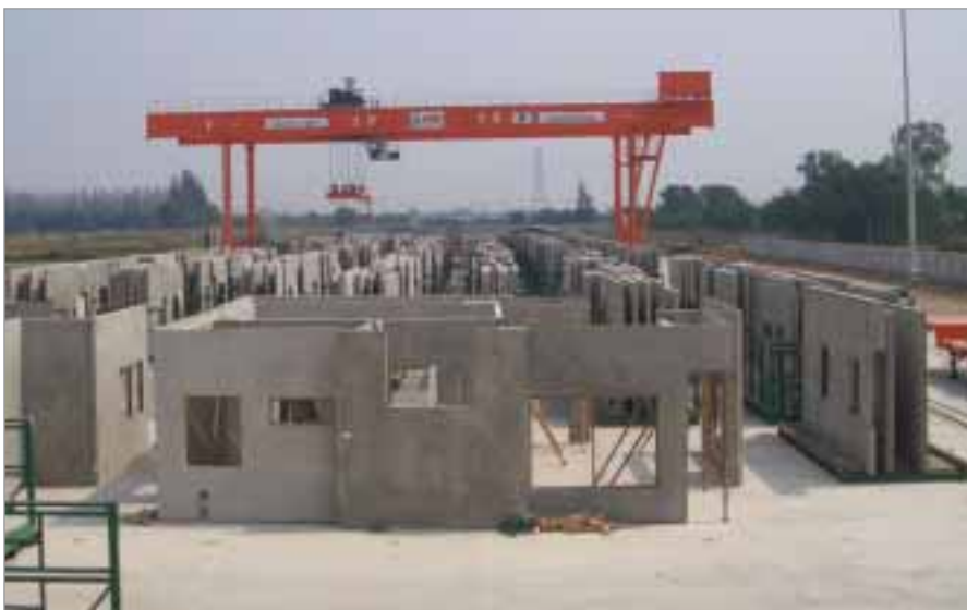
Portalkran und Lagerplatz
