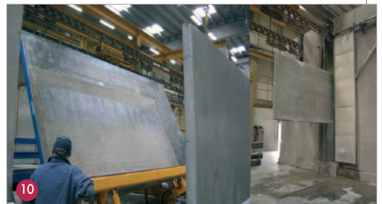
Abnahme des Betonfertigteiles auf dem Kipptisch, anschließend Auswaschen der Vorsatzbetonfläche in der Waschanlage
