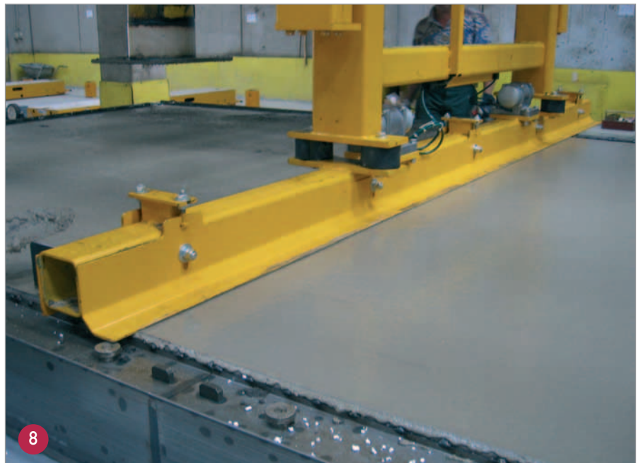
Bewehren auf Vorsatzbeton, danach Betonieren und Glätten der Normalbetonschicht
