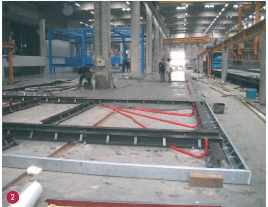
Fixierung und Montage von Einbauteilen auf dem vorhandenen Fußboden, Aufbetonieren des neuen Fußbodens.
