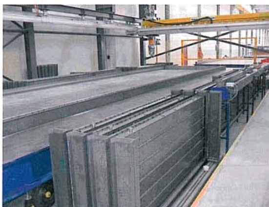
Fig. 1 Shuttering robot with shuttering pallet, in the foreground shuttering profiles stored in a magazine. Abb. 1 Schalungsroboter mit Schalungspalette, im Vordergrund Schalungsprofile magaziniert.
