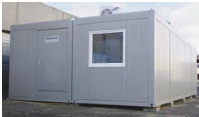
Kostensenkungspotenziale realisieren: Die gesamte Anlage wurde von Unitechnik im Doppel-Container vormontiert geliefert.
