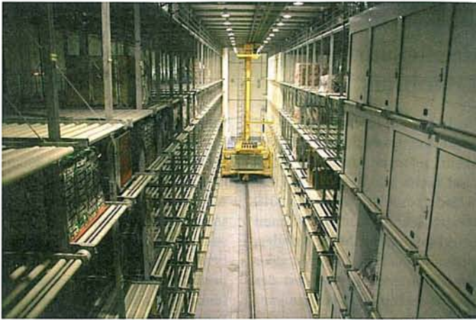
Bild 1: Im Mittelpunkt des Frischwarenterminals steht das ULD-Hochregallager
