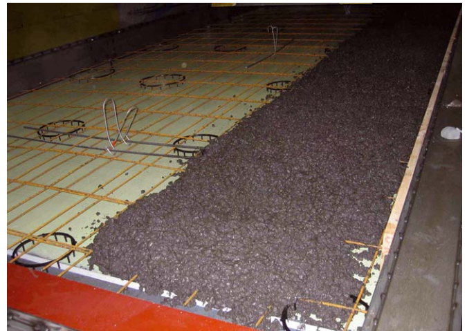
Betonieren der Vorsatzschale
