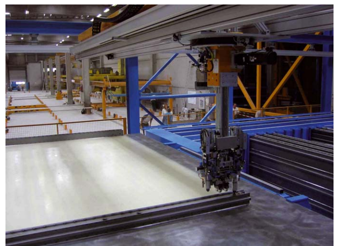
Der Schalungsroboter setzt die Schalungen nach dem Verzögererauftrag.
