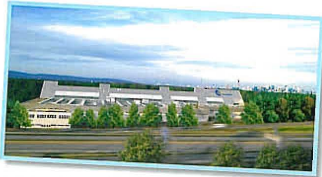
Die neue Cateringanlage von LSG Sky Chefs bei Frankfurt.
