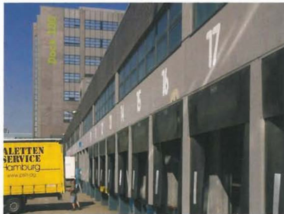
Dock 100 – ein Logistikzentrum, das von mehreren Mandanten genutzt wird
