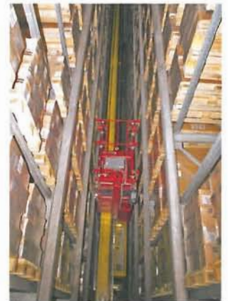
Neue Steuerungen: 40 m hohes Demag-Regalbediengerät
