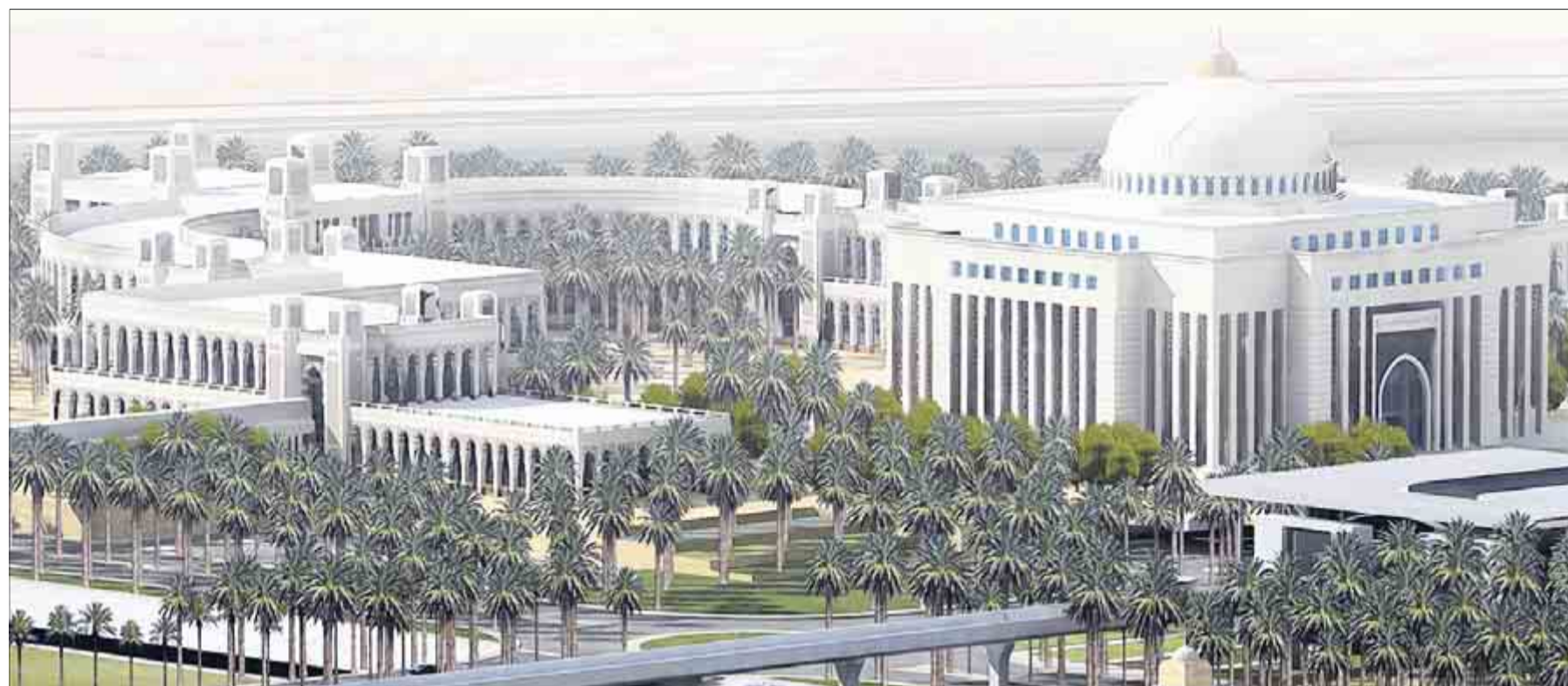
Der Kuppelbau im Zentrum des Campus ist das Wahrzeichen der „Princess Noura Bint Abdulrahman University“, die im Frühjahr 2012 eröffnet werden soll.
