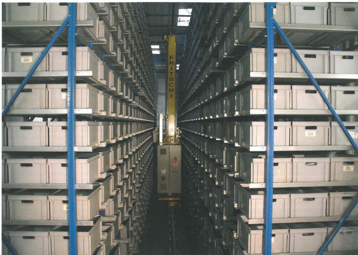
Kernstück des Logistikzentrums: AKL mit dreifachtiefer Lagerung
