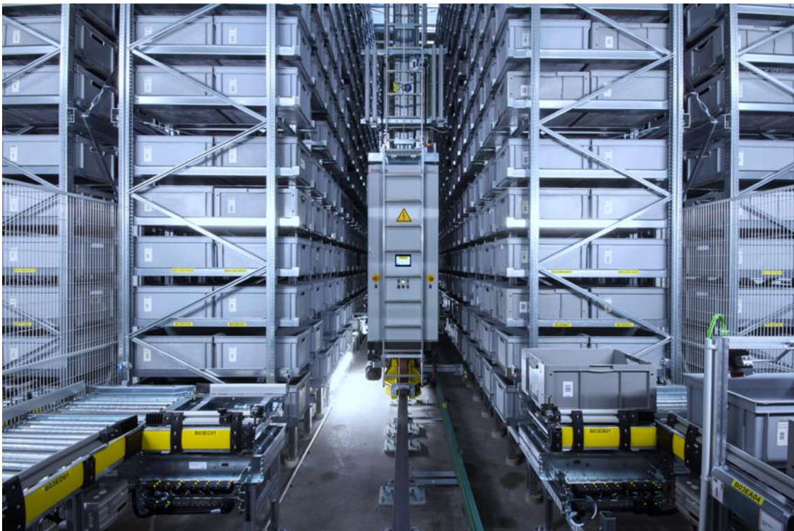
Automatisches Kleinteilelager mit Regalbediengeräten ©Unitechnik
