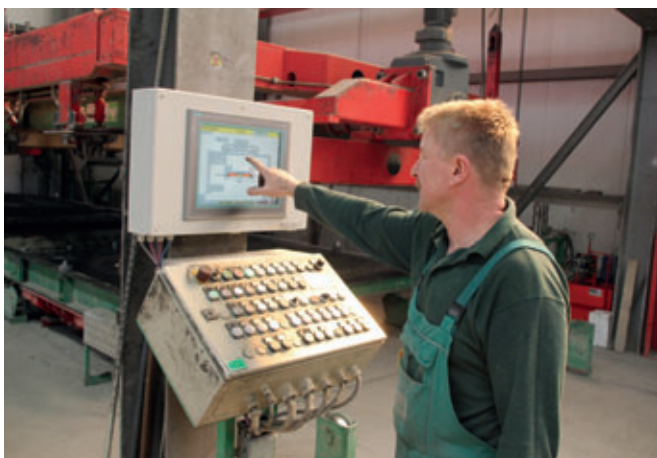
Nachrüstung eines Touchscreen im Rahmen der Modernisierung
